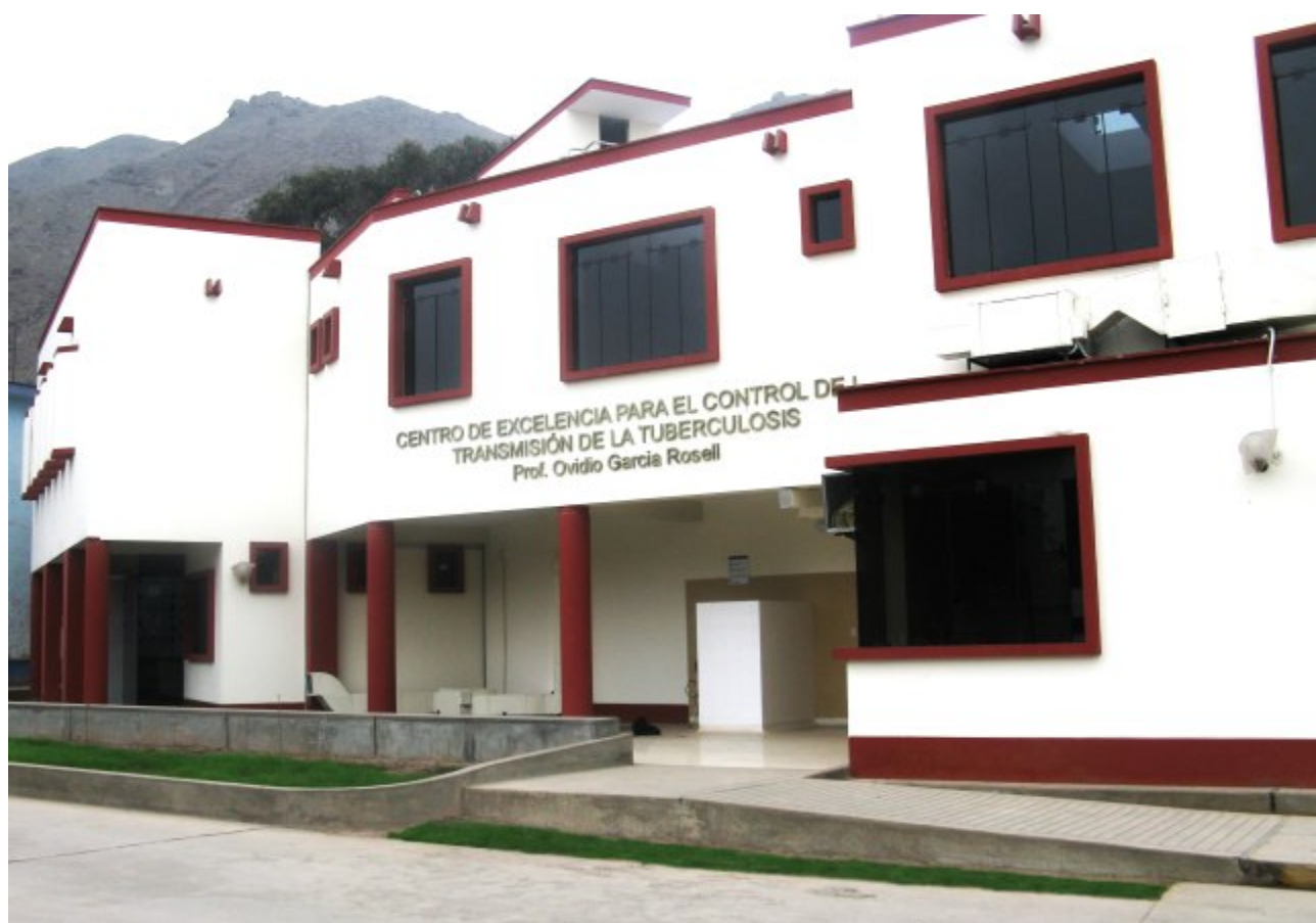
Fachada del Centro de Excelencia para Atención de la Tuberculosis
